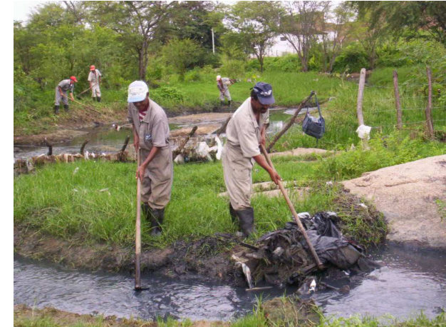
Limpeza e Drenagem
